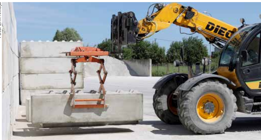
«Legoklotsideks» nimetatavaid plokke saab kasutada ilma seguta, näiteks müüritiste rajamiseks: tõstad plokki paika, plokide taldmikus olevad õnarused lukustuvad alumise plokirea peal olevate nagadega – ja kiirelt püstitatav müür ongi valmis.
