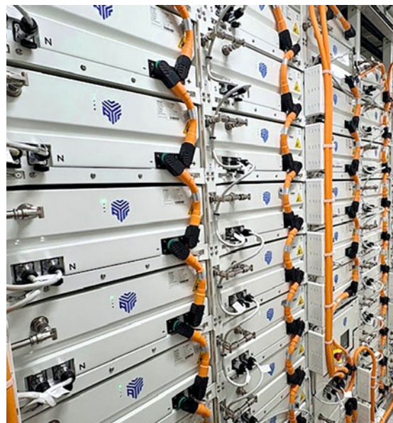
Reeder paigaldas tänavu talvel dokis olnud „Finlandia“ 9. tekile 1,4 MW akukonteineri. Selles on 93 akumoodulit, igaüks kaalub 100 kg. Fotol on akud näha konteineri sees ja väljastpoolt.
